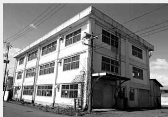
▲解体された空き工場
