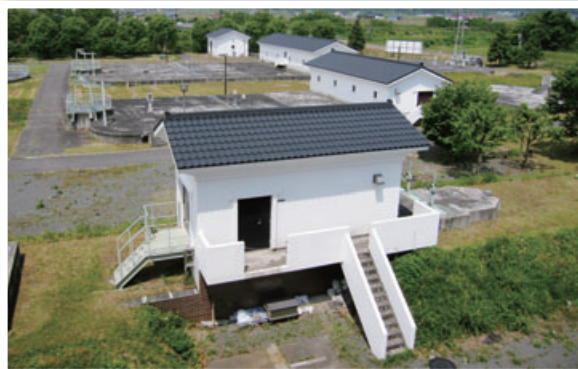
喜多方浄化センター
