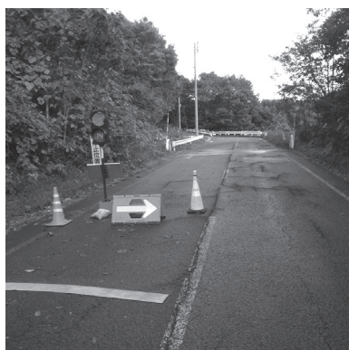
▲仮復旧中の新村・三ノ倉線
