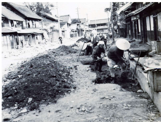
昭和30年代の道路工事の様子
