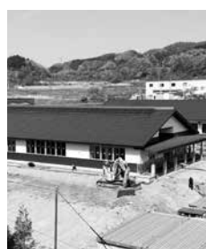
▲建設中の山都公民館
