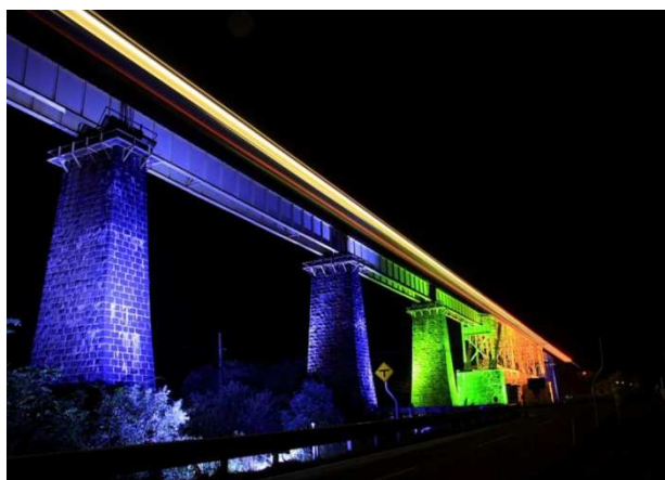
一ノ戸橋梁ライトアップ
