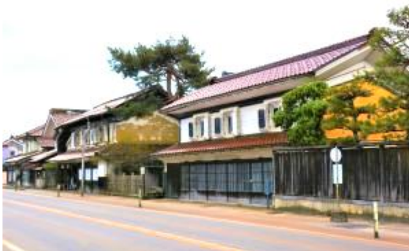
小田付伝統的建造物群保存地区
