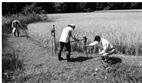
▲電気柵設置風景
