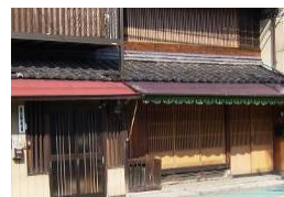
建築物と一体的な形態の室外機
