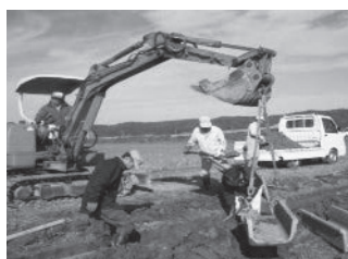
▲長寿命化のための水路の更新作業例
