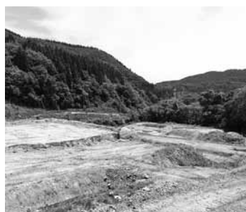
▲農地災害復旧工事の現場
