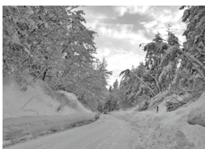
▲上三宮町宮川の支障木・危険木
