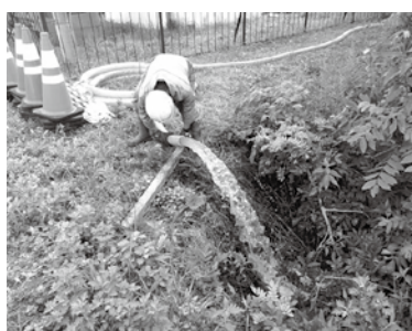
▲放流の試運転状況
