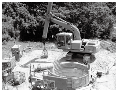
▲集水井の掘削工事
