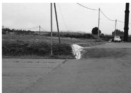
▲残土の状況（左側）
