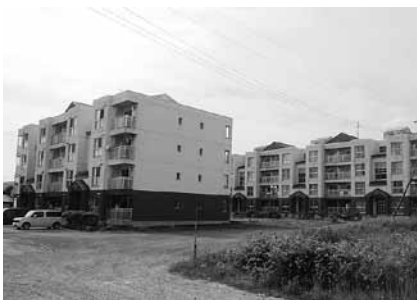
▲喜多方市営住宅
