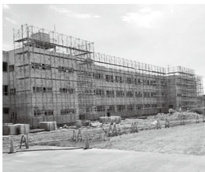
▲解体中の旧商業高校校舎
