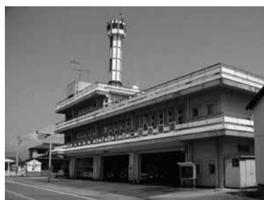
▲現喜多方消防庁舎
