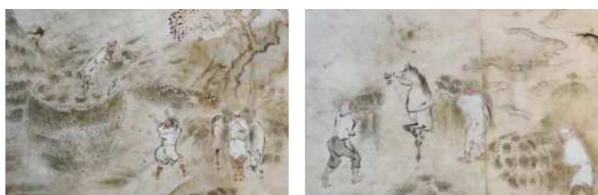
取入の部分拡大写真
