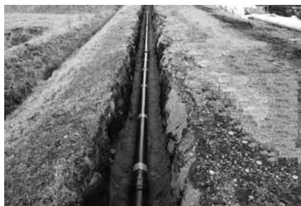
▲入田付上水道・送配水管布設工事
