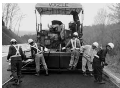
▲道路改良舗装工事
