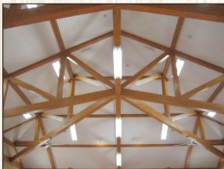
【多目的ホール屋根組】
