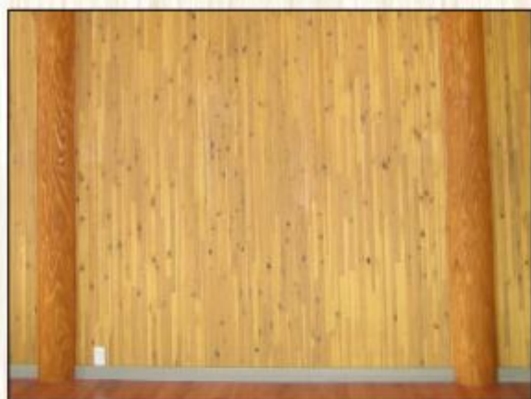
【スケルトンウッドパネル施行部分】
